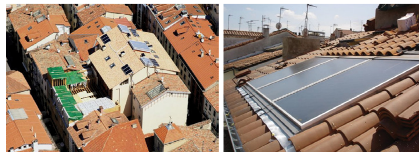
Figura 13 Sistemas solares térmicos no centro histórico de Vitoria-Gasteiz.
