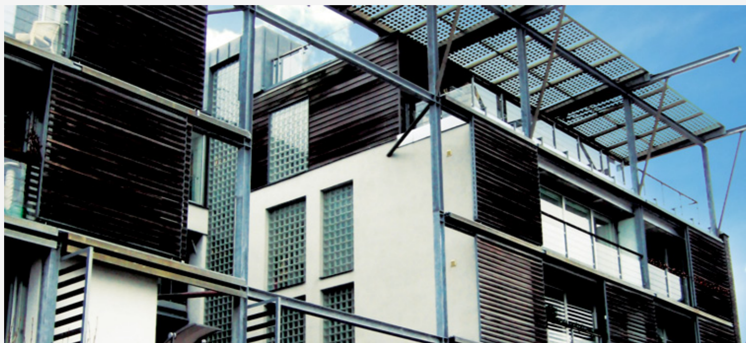
Figura 10 Edifício em Western Harbour, Malmö, que integra painéis fotovoltaicos como dispositivos de sombreamento
