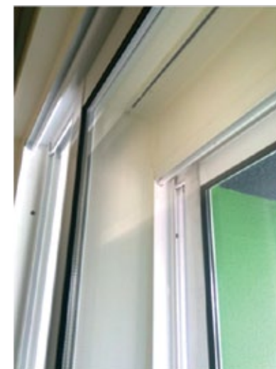
Figura 11 Pormenor de vão duplo com janelas de vidro duplo
