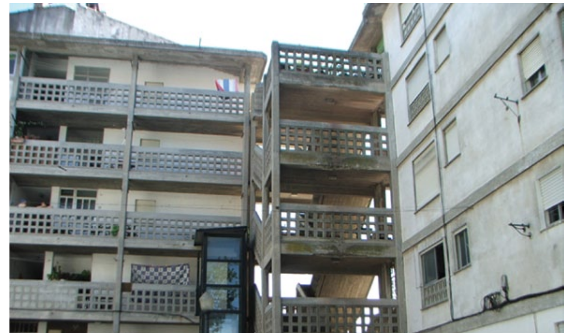
Figura 03 Vista geral do edifício
